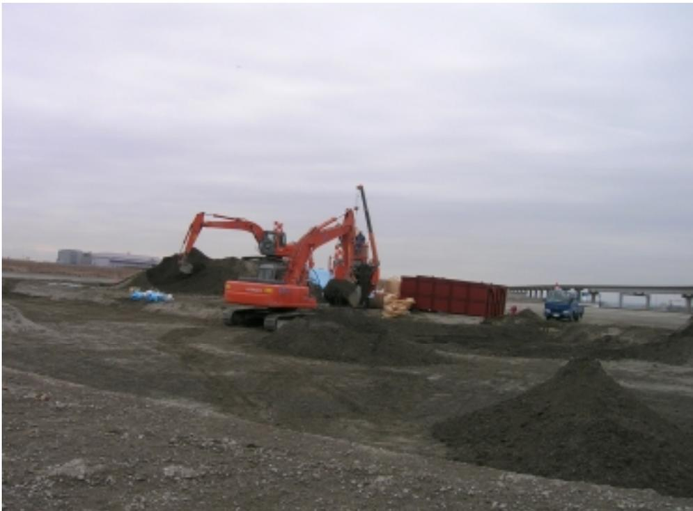
砒素不溶化完了後 埋め戻し
