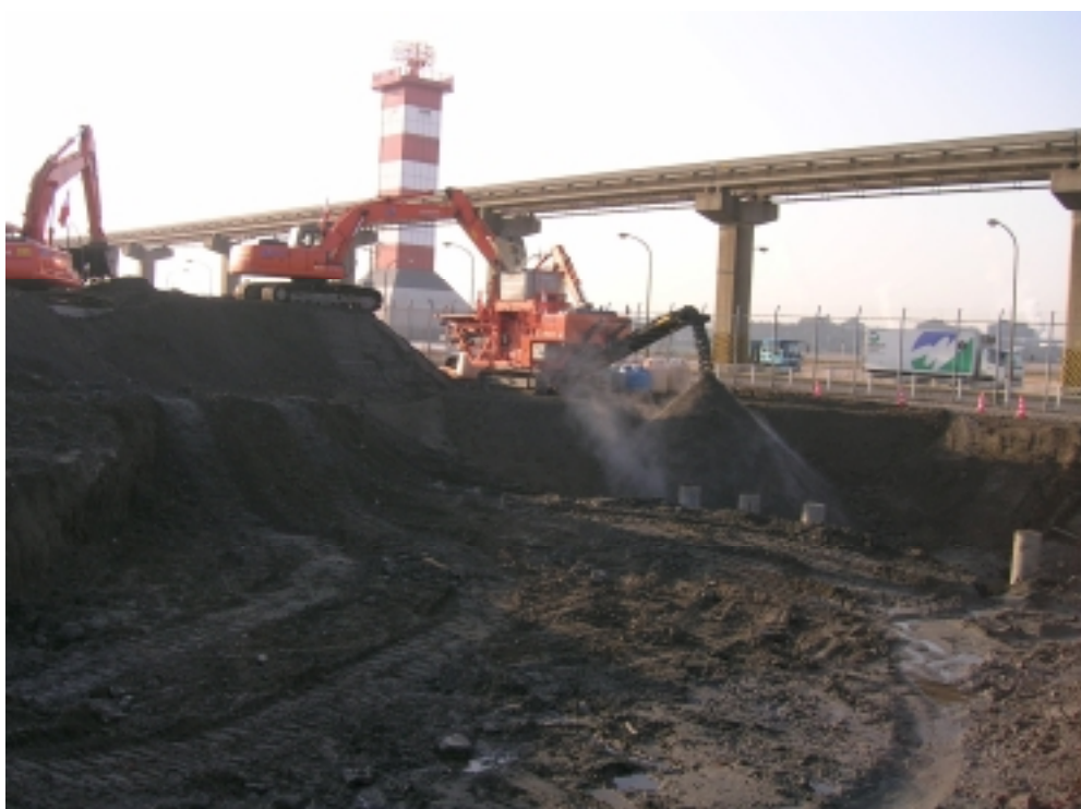
油分处理施工状况
