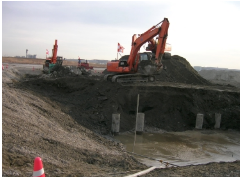
砒素部分掘削
