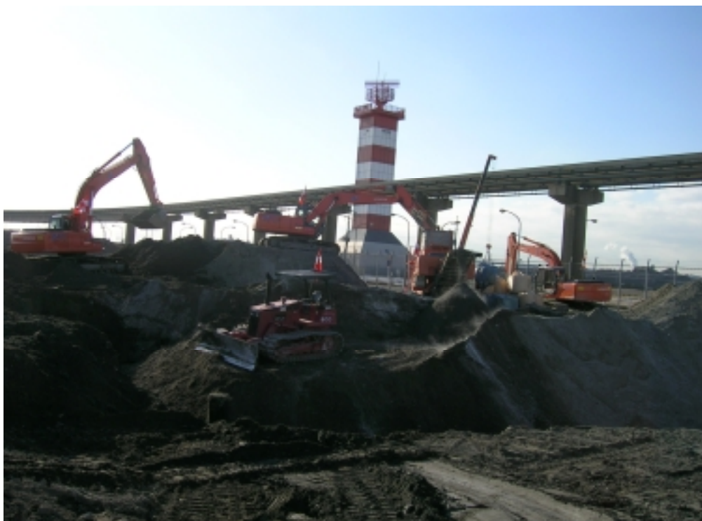
油分处理施工状况
