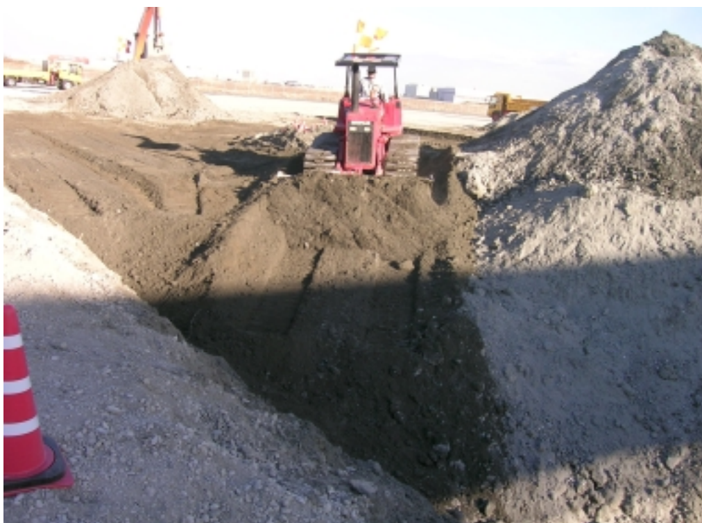
埋め戻し状況
