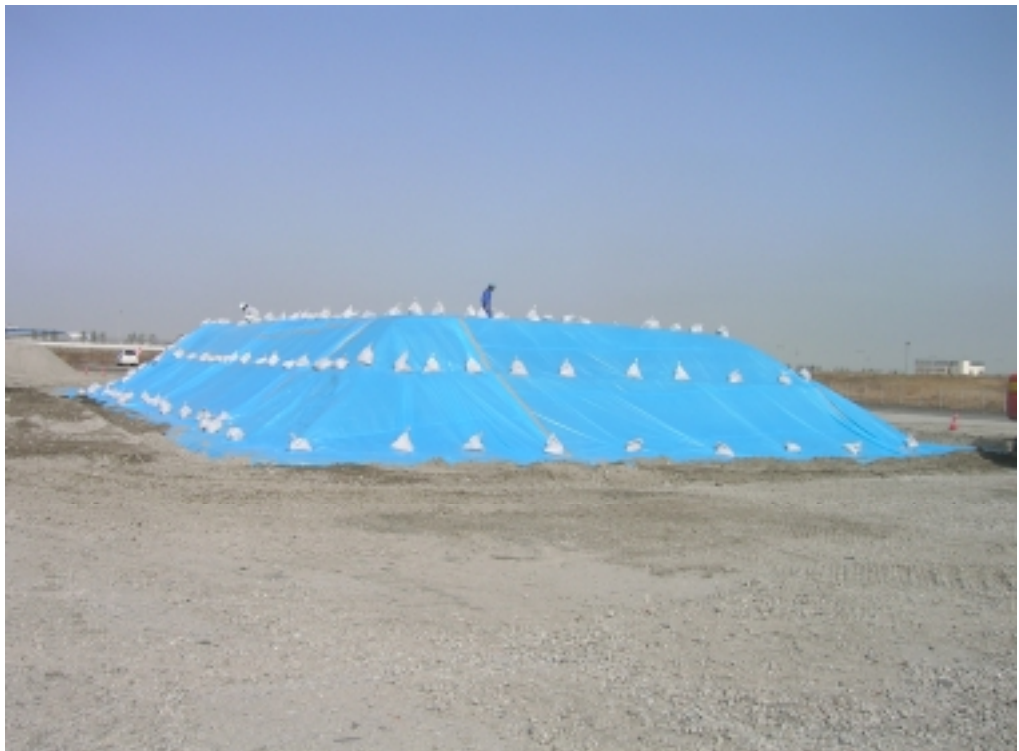
砒素混入土仮置き
