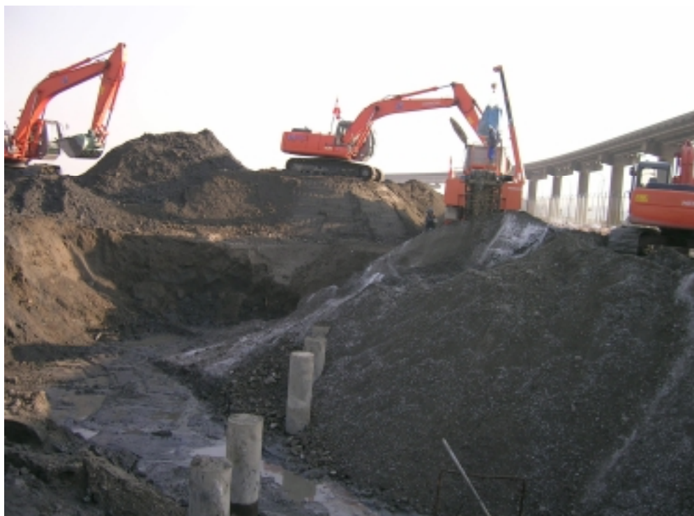
油分处理施工状况
