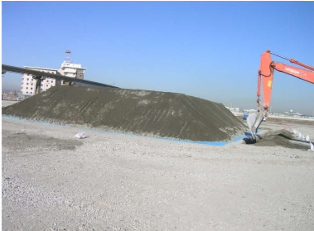
砒素混入土仮置き
