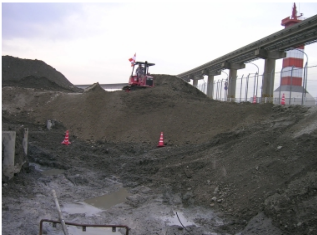
埋め戻し状況
