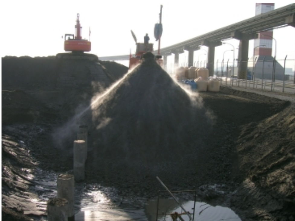
油分处理施工状况
