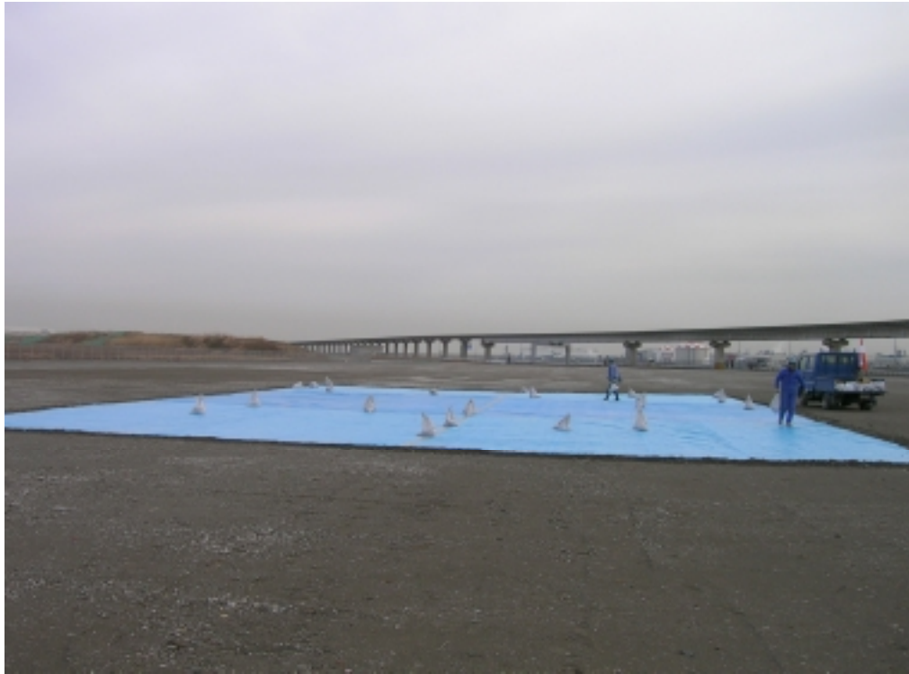
砒素混入土仮置き(下部シート設置)
