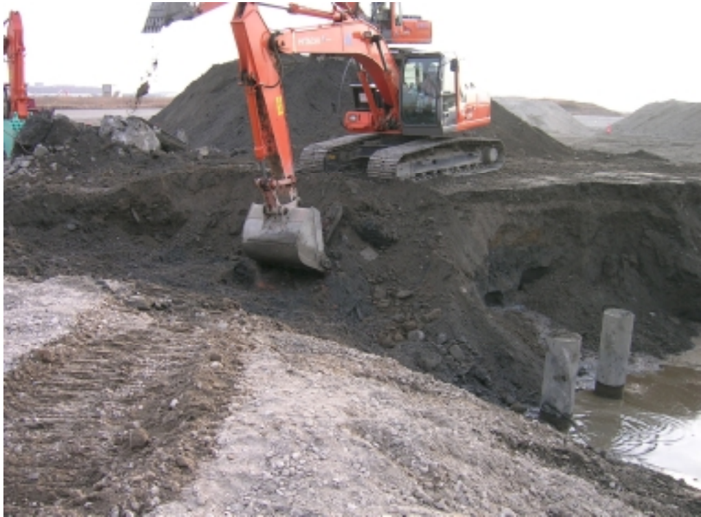
砒素部分掘削
