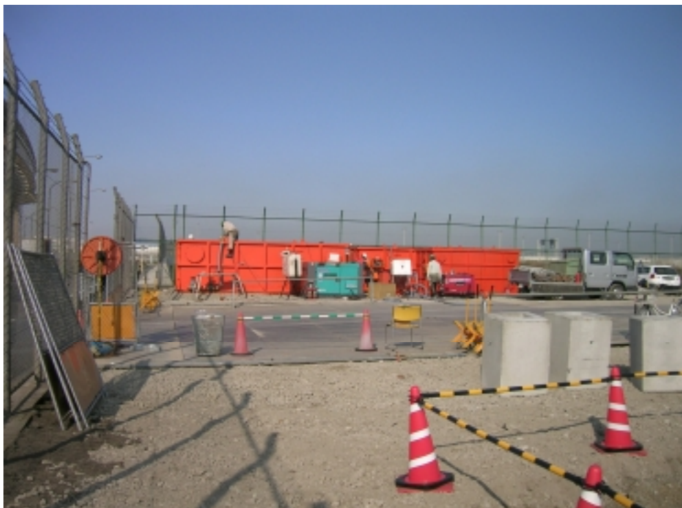
排水プラント
