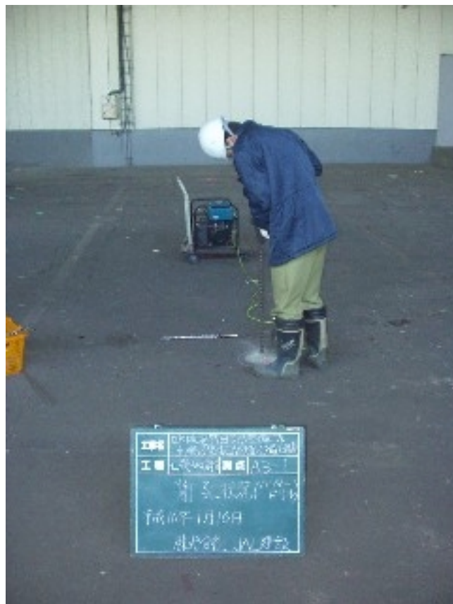
削孔状況 (A3-1)
