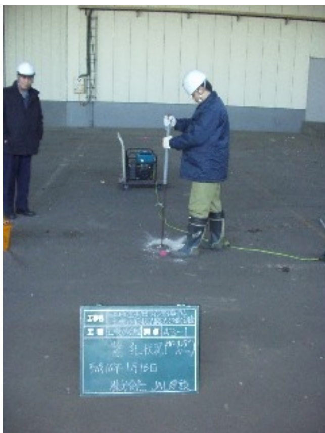
ボーリングバー削孔状況 (A3-1)
